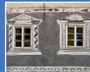
Fenstermalerei im Detail
