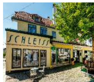
Schleiss-Doppelhaus Ostseite, Kreuzung Stadtheater
