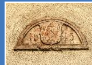
Mauerdetail Gebäude Vorderfront
