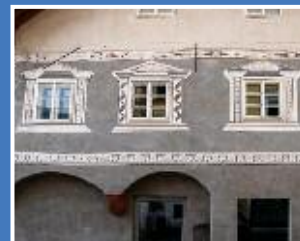
Detail Vorbau u. Fenstermalerei
