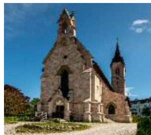
Evangelische Kirche 2021, Westseite Eingangsbereich
