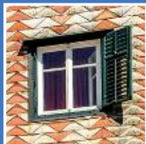
Details Türen und Fenster Bilder oben und unten
