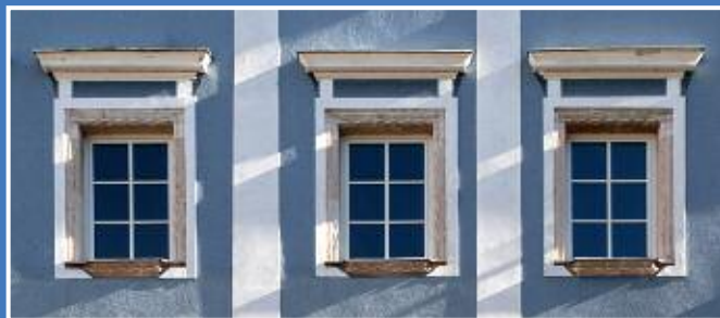
Details Fensterfront, Fenstereinfassung, Rahmen und Fenstersims
